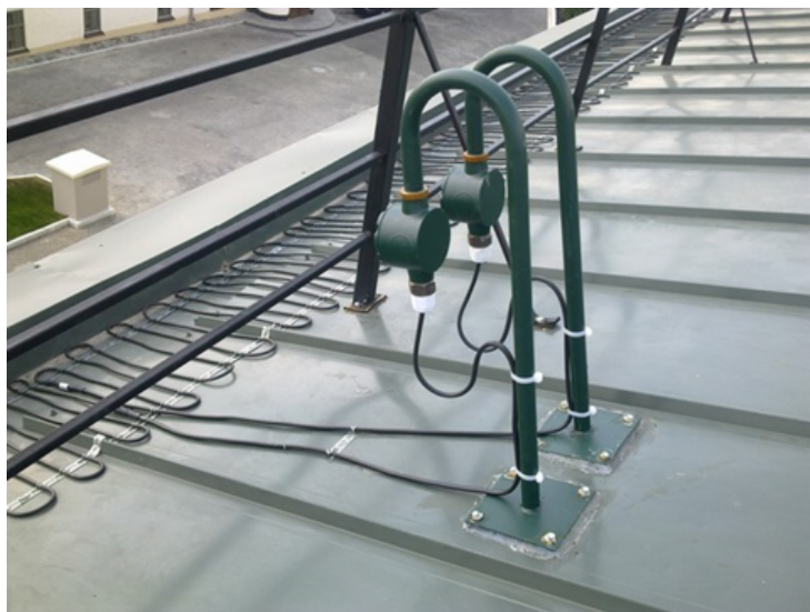
Рис. 3. Монтаж нагревательного кабеля на крыше. ДЕВИ Snow-30Т
